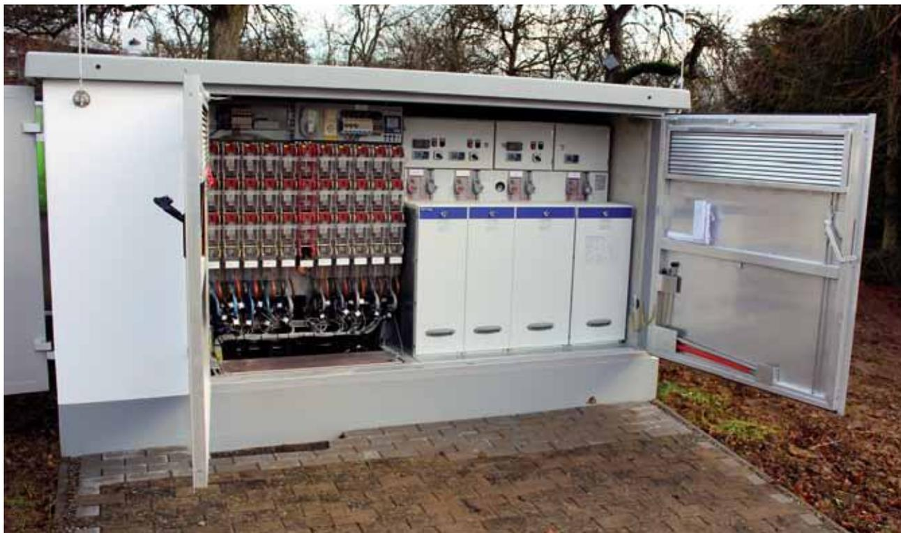
Bild 2. Frontansicht der Station mit Niederspannungsverteilung (links) und Mittelspannungsschaltanlage
