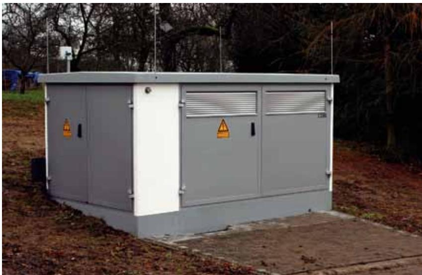
Bild 1. Außenansicht der intelligenten Ortsnetzstation
