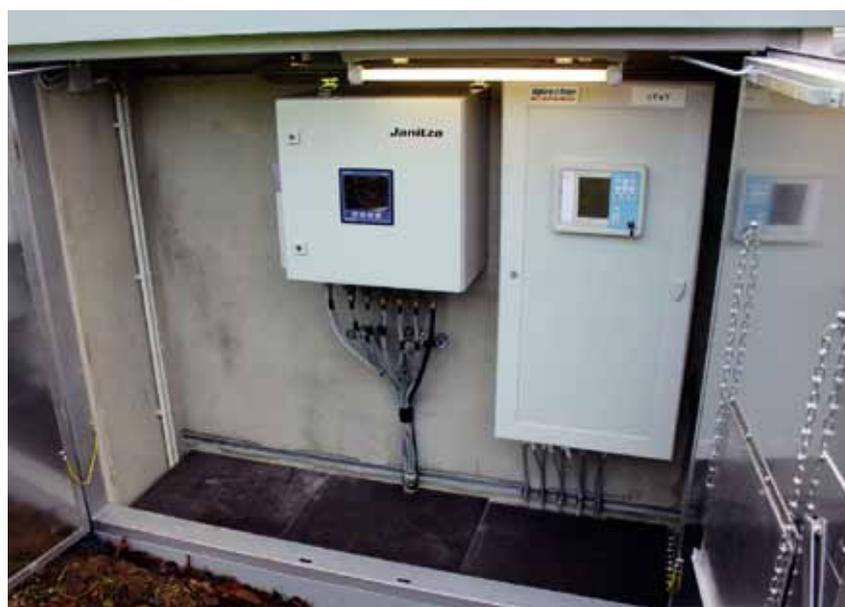
Bild 3. IKT-Nische mit Fernwirschrack (rechts) und Zusatzbox für die Niederspannungsmessung
